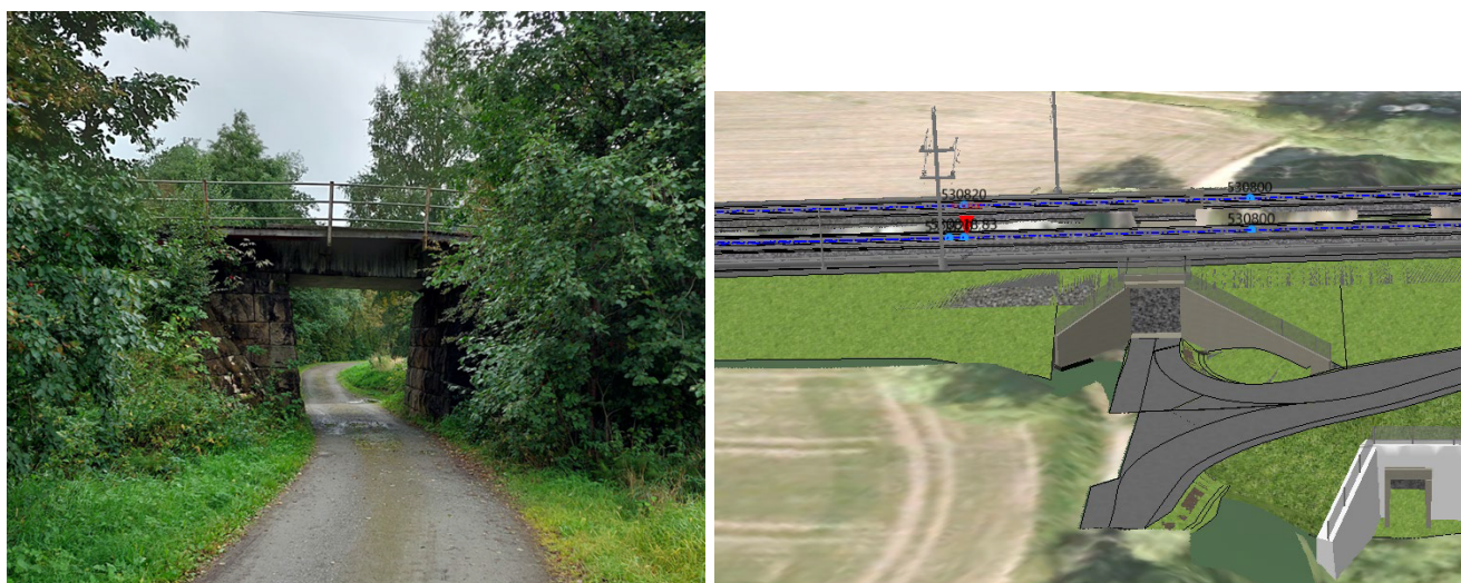
Figur 5: Dagens kulvert til venstre, ny kulvert til høyre
